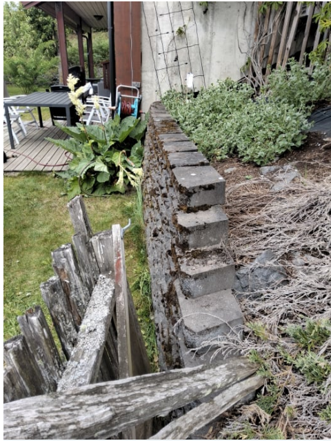
Støttemur på nedsiden av boligen.
