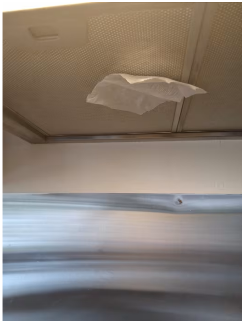
Kjøkkenventilator er testet med papir.
