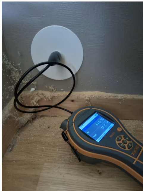
Bilde fra fuktmåling i veggkonstruksjon tilstøtende våtsone.
