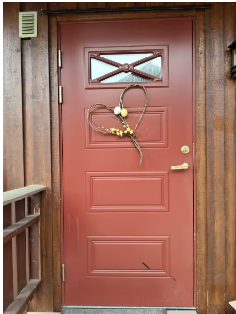
Boligen har profilert entredør med glassfelt.
