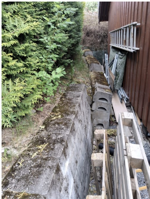
Støttemur bak garasje.
