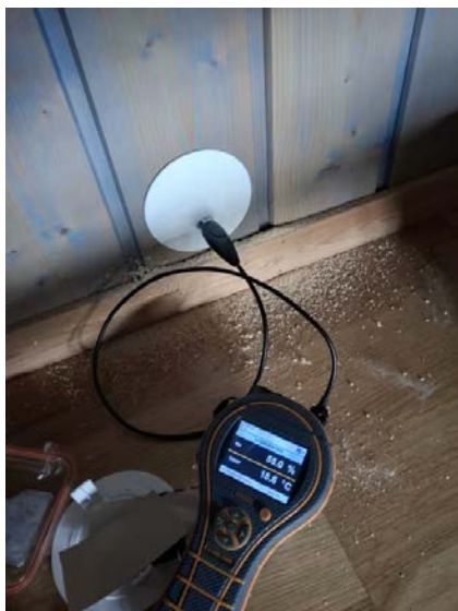
Bilde fra fuktmåling i utlektet veggkonstruksjon under trapp.
