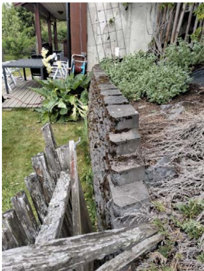
Støttemur på nedsiden av boligen.
