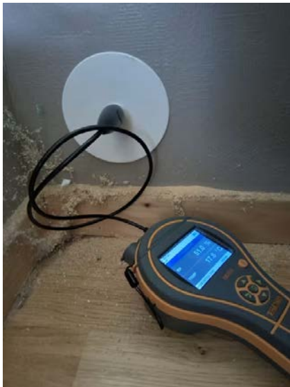
Bilde fra fuktmåling i veggkonstruksjon tilstøtende våtsone.
