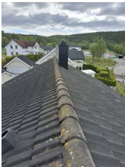
Taket er oppført med saltakskonstruksjon.
