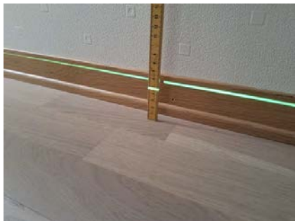
Etasjeskille er kontrollert med nivelleringslaser.
