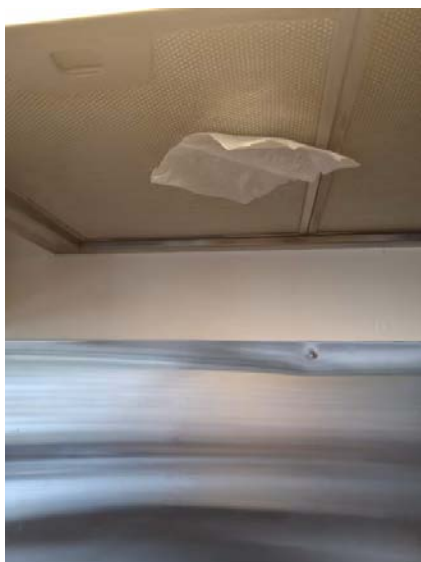
Kjøkkenventilator er testet med papir.
