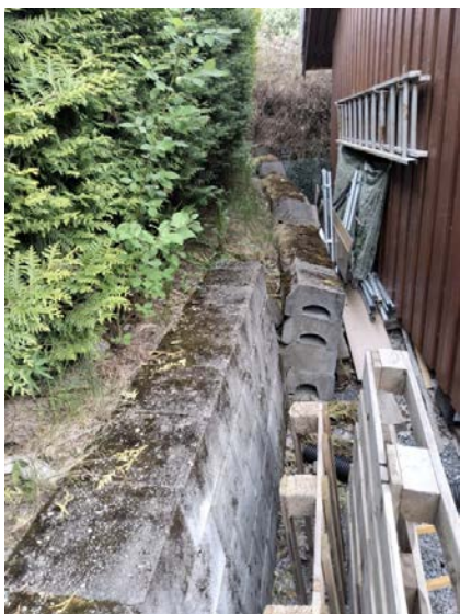
Støttemur bak garasje.
