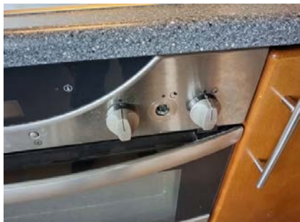
Defekt bryter på integrert stekeovn.
