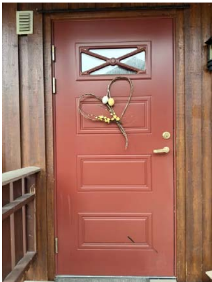
Boligen har profilert entredør med glassfelt.
