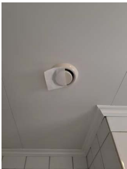
Avtrekk er testet med papir.
