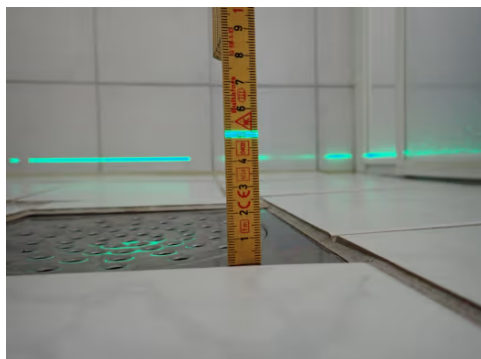
Referansenivå laser til topp tettesjikt under flis ved dør = ca. 5 cm. Viser ca. samme høyde til topp slukrist.
