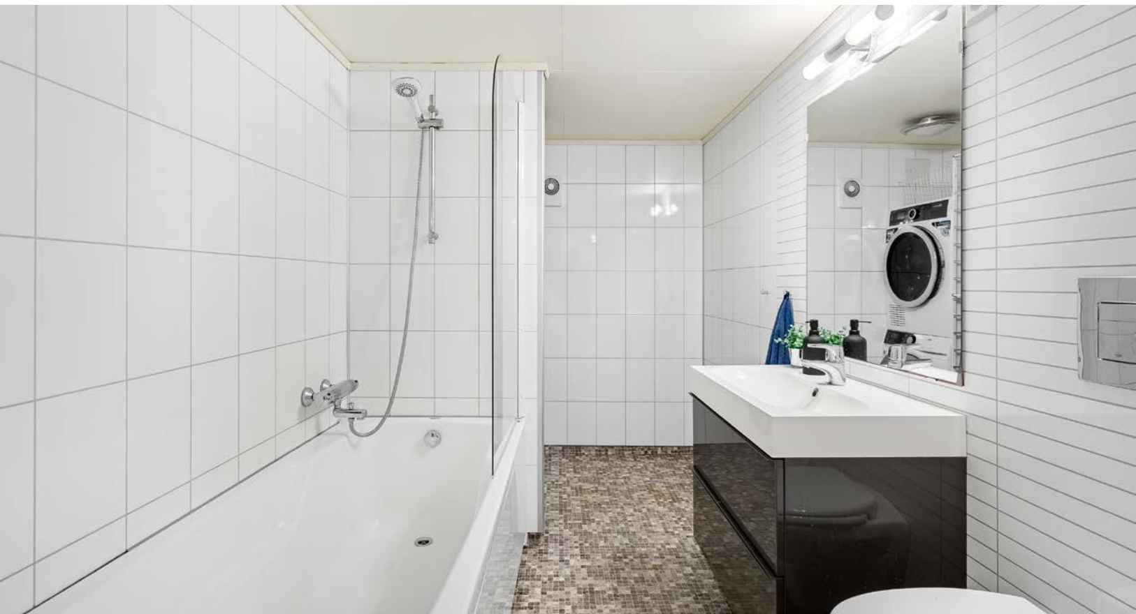
Bad/vaskerom. Innredet med vask i seksjon, veggghengt toalett, badekar og opplegg for vaskemaskin og tørketrommel. (ikke godkjent)
