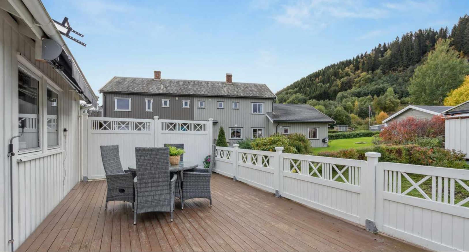
Terrassen ved inngangspartiet har tredekke, hvitmalt rekkverk og skjermende levegg i ene enden.
