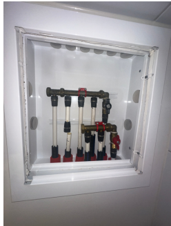
Samleskap med rørkurser og stoppekraner
