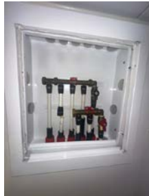
Samleskap med rørkurser og stoppekraner
