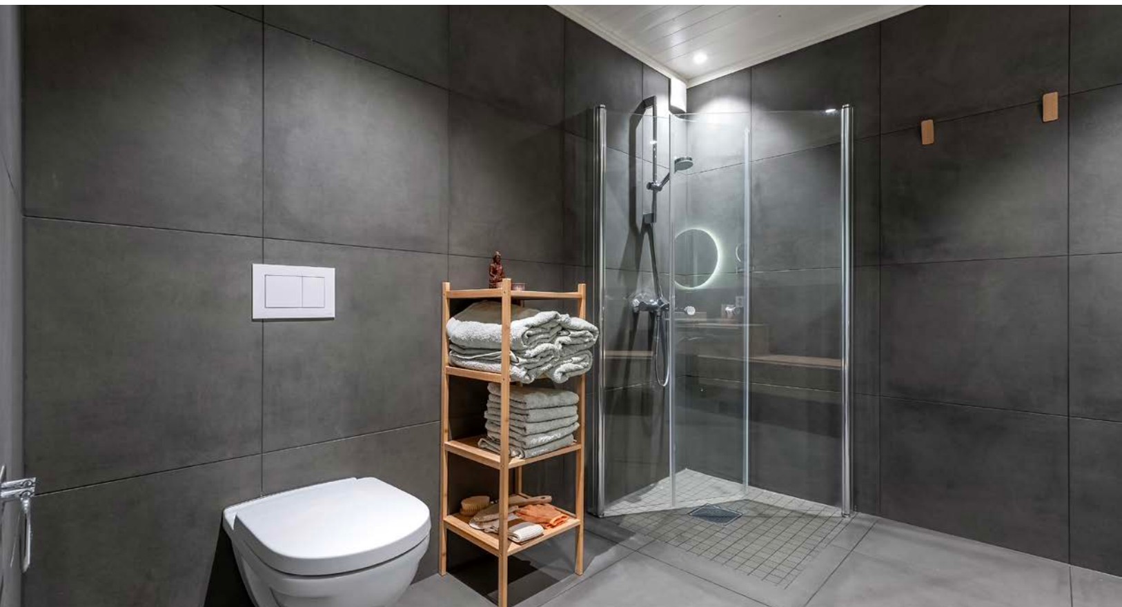
Vegghengt wc med innbygd systerne og dushjørne med innfellbare glassdører
