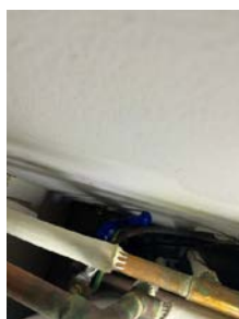
Stoppekran bak innebygget bereder
