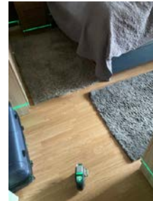
Høydemåling i soverom i 1. etasje.
