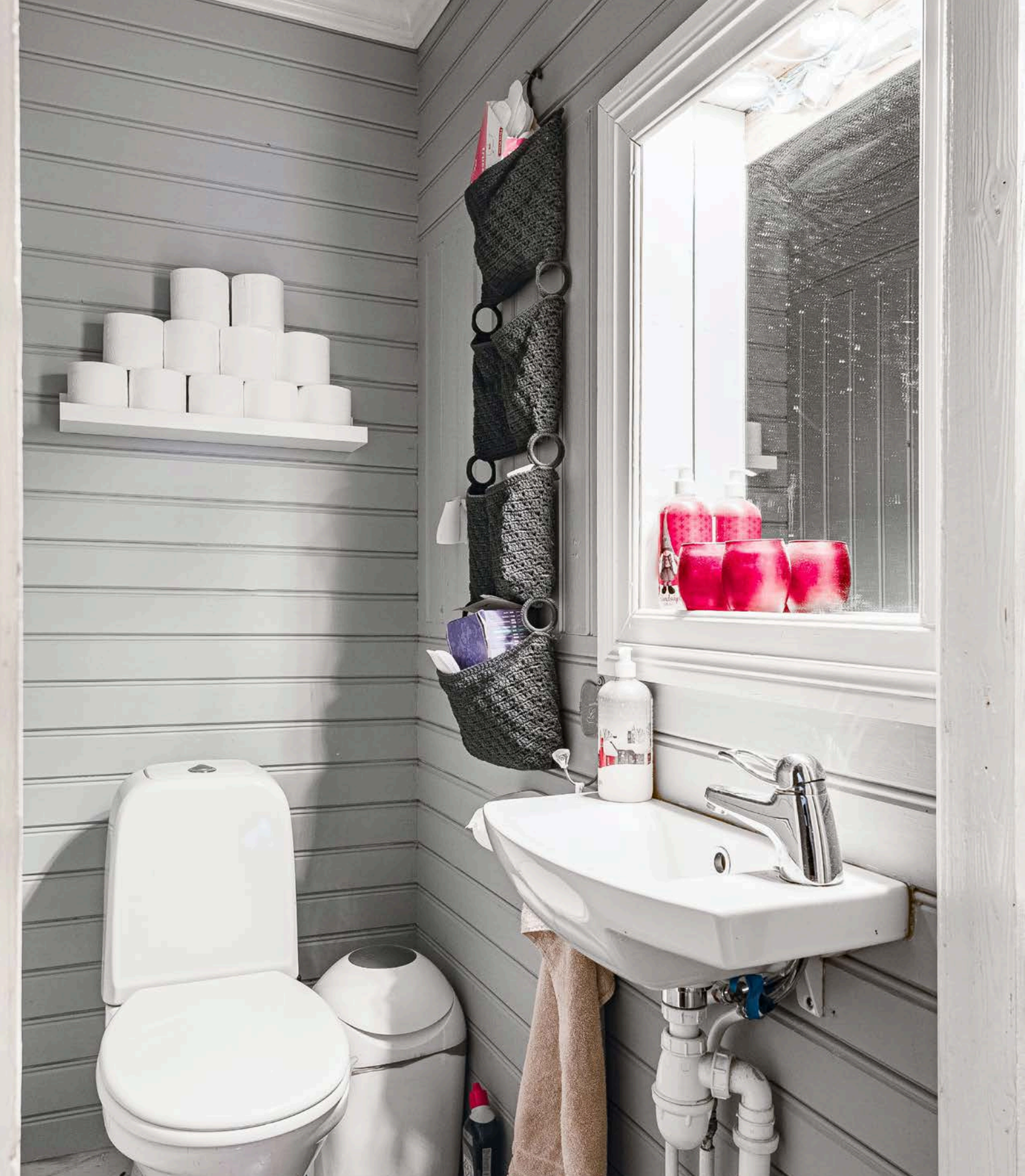
Toalettrom med vegghengt servant og gulvstående toalett.
