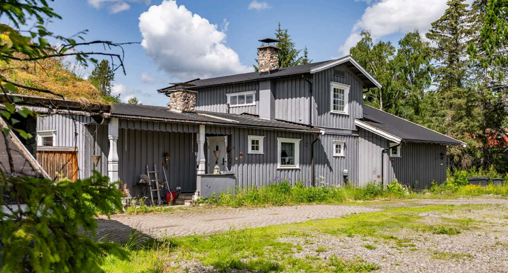
Enebolig fra 1940 med diverse oppgraderinger på 1980/90-tallet og tilbygget med hybler i 1998.
