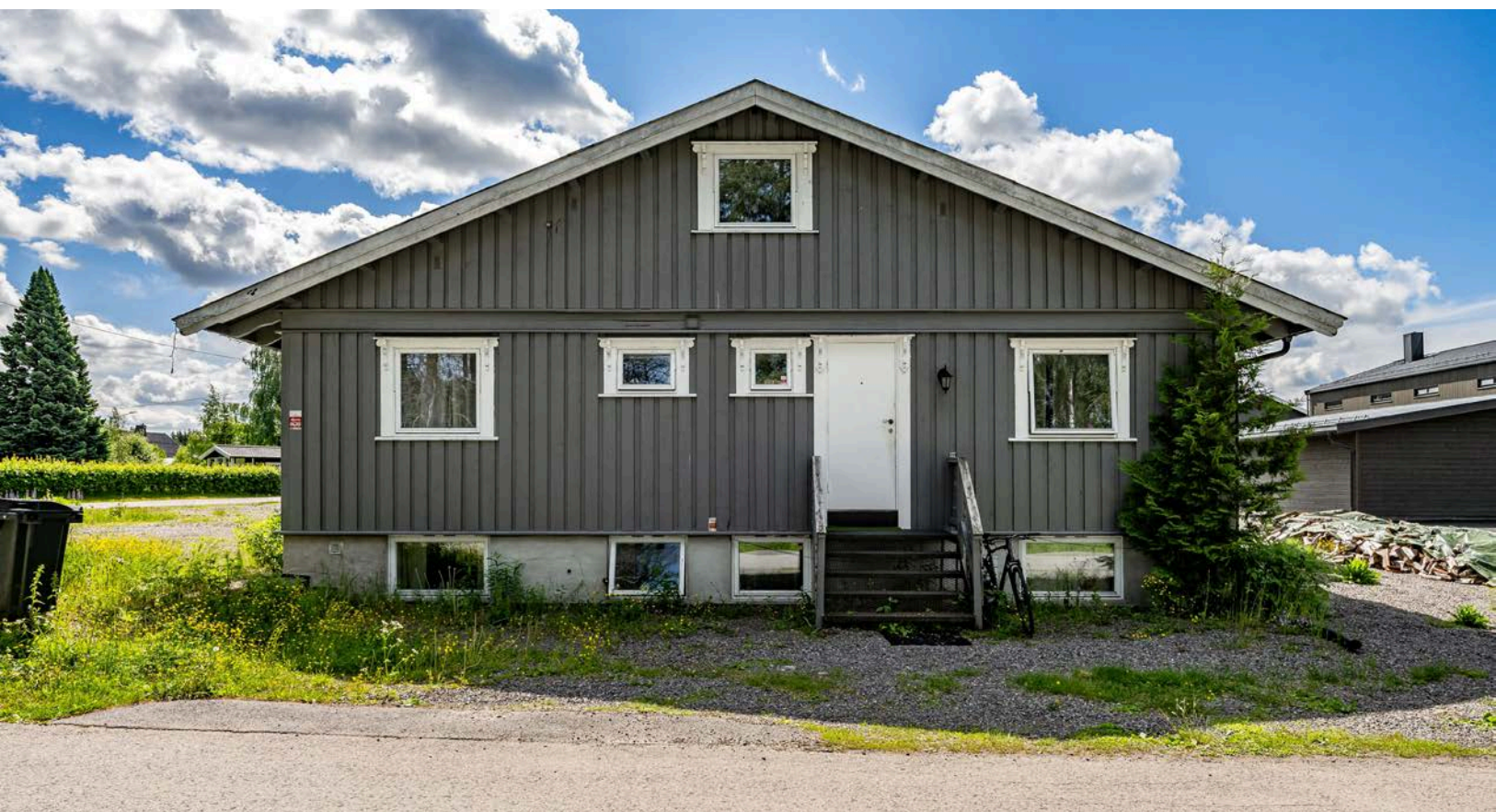
Enebolig fra 1940 tilbygget med hybler i 1998.
