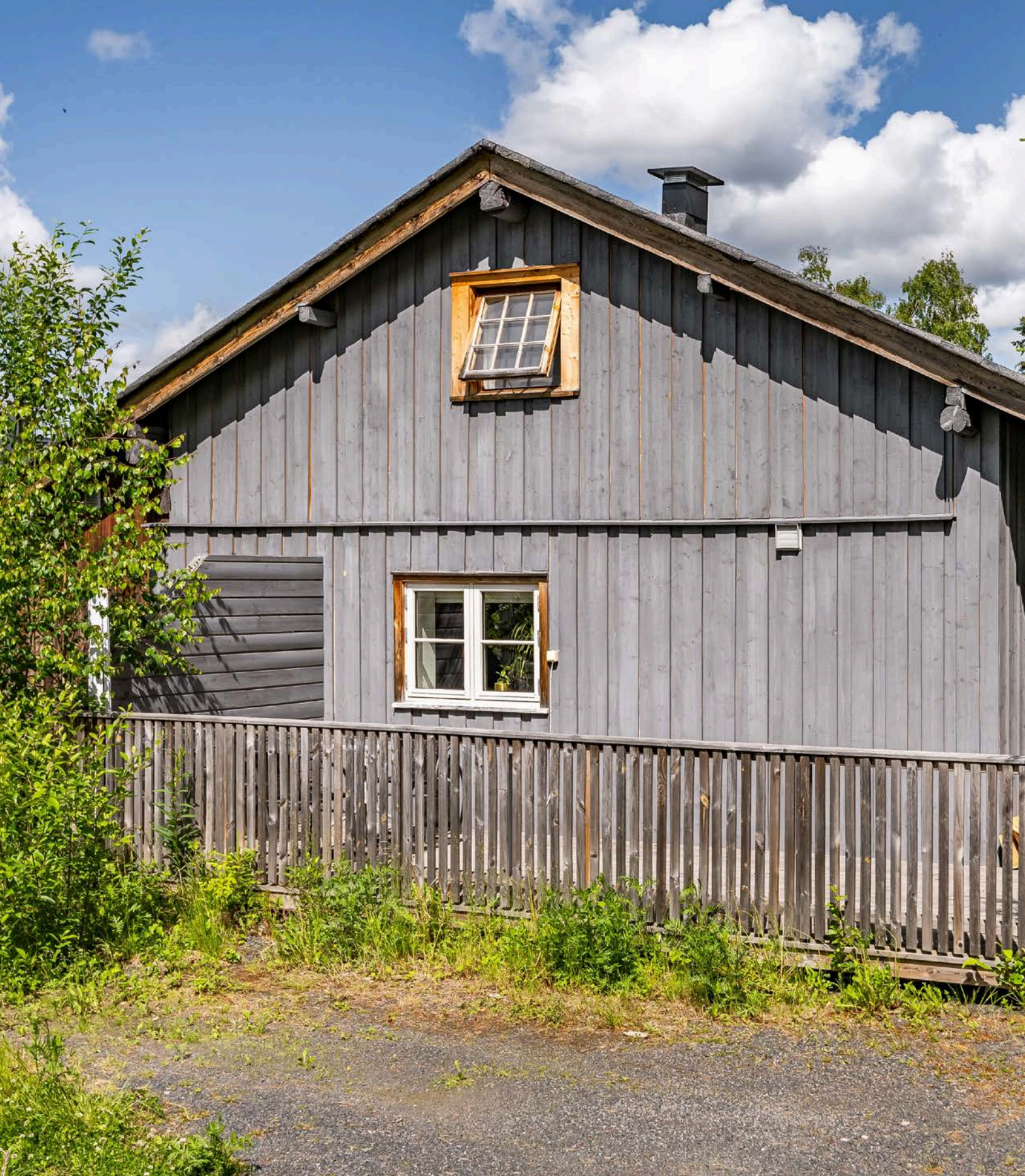
Eldre laftet bolig fra 1980/90-tallet med inntilbygget garasje, ombygget/modernisert til hybelleilighet i 2013/14.
