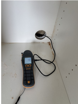
Bilde hulltaging og måling av fukt
