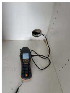
Bilde hulltaging og måling av fukt
