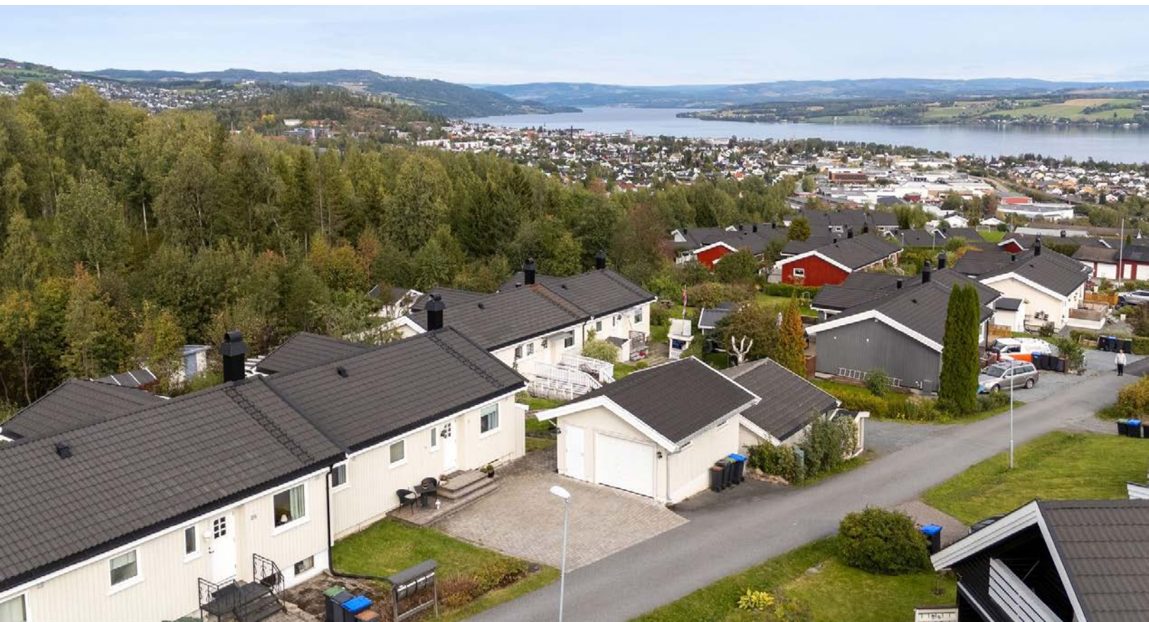
Parkering ved boligen.
