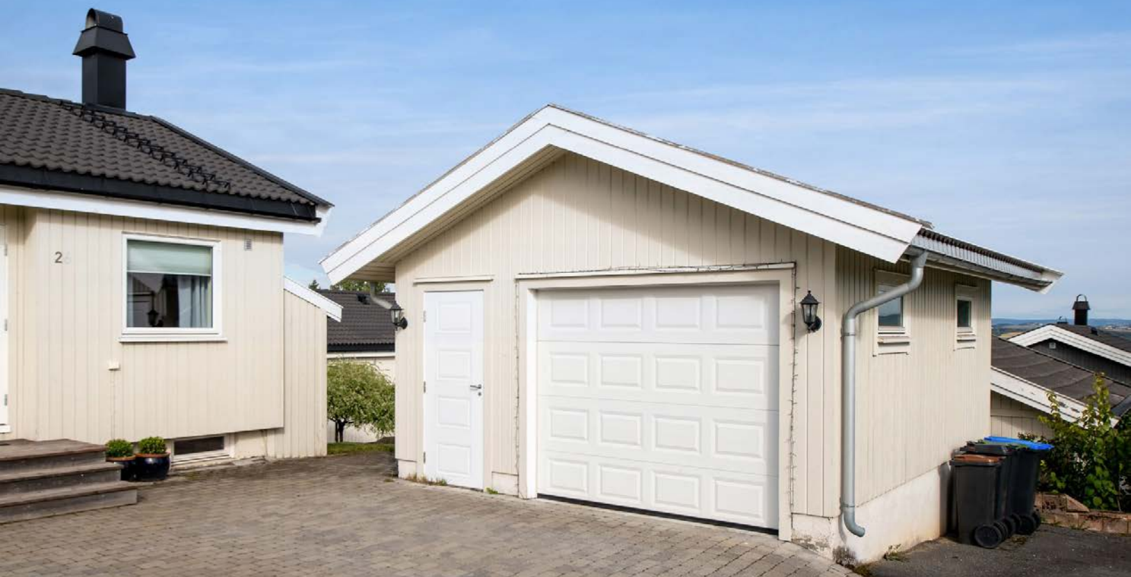
Garasje på eiendommen.
