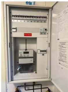
Bildet viser kabler som ikke er tilstrekkelig festet.
