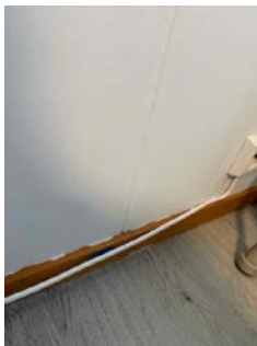
Bildet viser kabler som ikke er tilstrekkelig festet.
