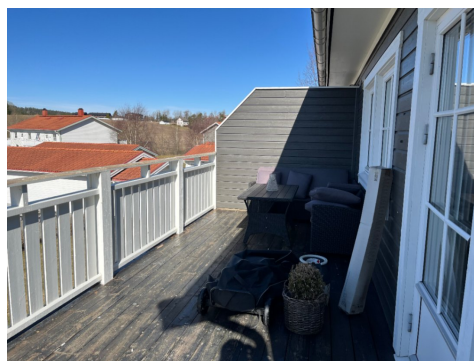
Veranda med pågående vedlikehold av gulv.
