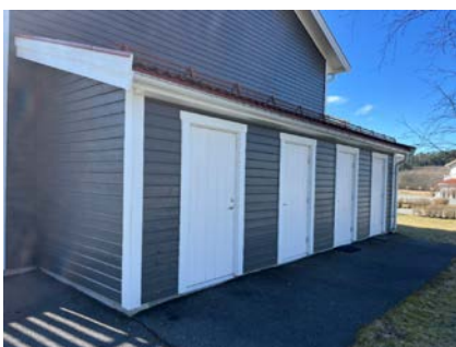
Felles tilbygg med boder.
