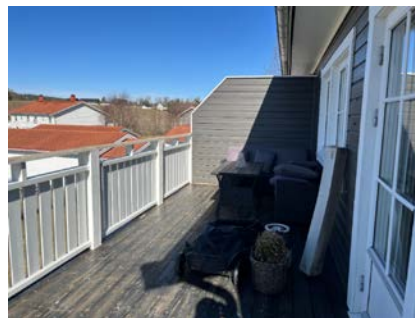
Veranda med pågående vedlikehold av gulv.
