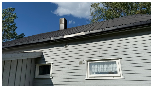
Taktekking sett fra bakkenivå
