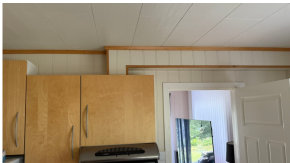
Eksempel på platekledning på vegg utenpå pipen
