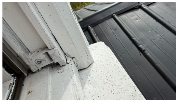
Eksempel på feil beslag og omramningsløsning.
