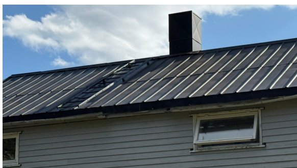
Taktekking sett fra bakkenivå
