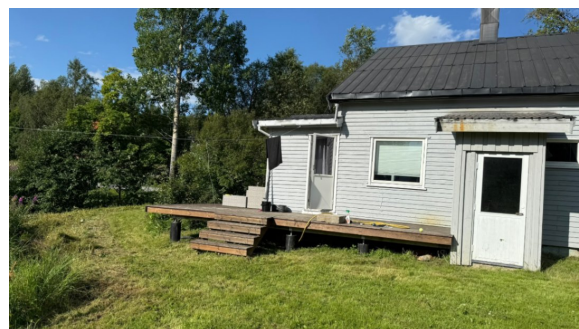
Manglende rekkverk
