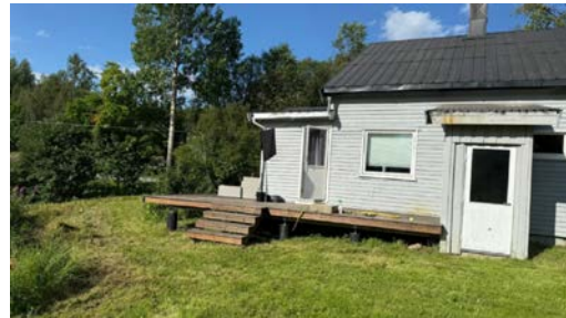
Manglende rekkverk
