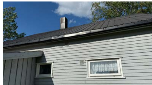
Taktekking sett fra bakkenivå
