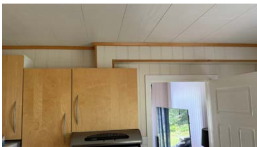
Eksempel på platekledning på vegg utenpå pipen
