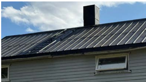
Taktekking sett fra bakkenivå
