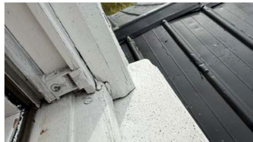
Eksempel på feil beslag og omramningsløsning.
