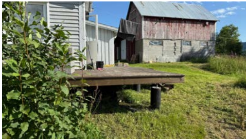
Manglende rekkverk
