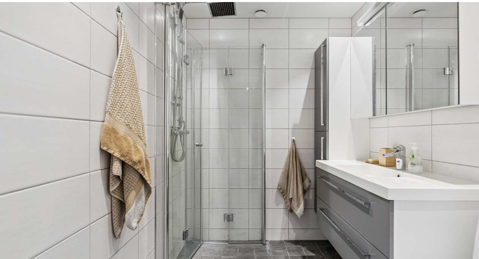
Lekker flislagt bad med gulvvarme
