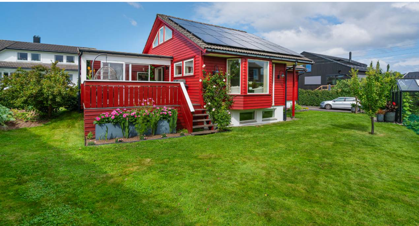
Boligen er oppgradert utvendig og innvendig i nyere tid og fremstår med en gjennomgående god standard
