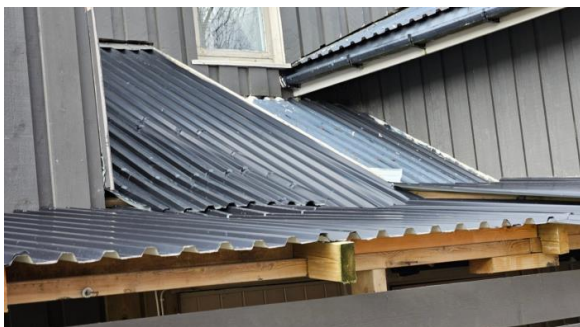
Ufagmessig legging av takplater.
