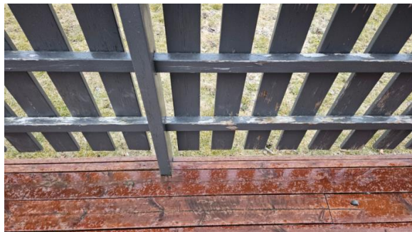
Malings avflassing av rekkverk
