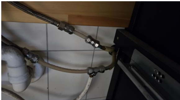
Kontroll av røropplegg.
