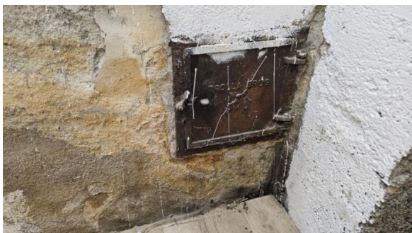
Kontroll av sotluke.
