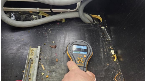
Det ble ved befaring fuktmålt i benkeskap og foran oppvaskmaskin, ingen forhøyede verdier ble registrert.
