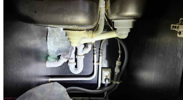
Kontroll av røropplegg.
