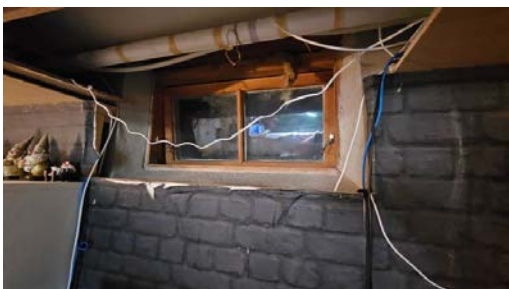
Adkomst til krypkjeller.
