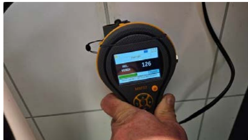
Det ble ved befaring fuktmålt på vegg, ingen forhøyede verdier ble registrert.
