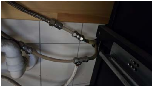
Kontroll av røropplegg.
