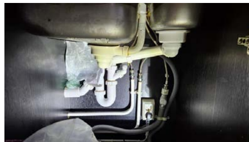
Kontroll av røropplegg.
