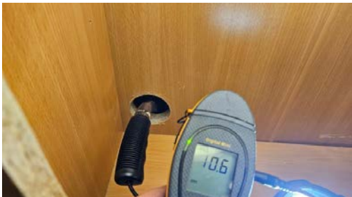
Det ble ved befaring fuktmålt i vegg i kjellerstue, ingen forhøyede verdier ble registrert.
