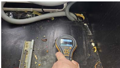
Det ble ved befaring fuktmålt i benkeskap og foran oppvaskmaskin, ingen forhøyede verdier ble registrert.
