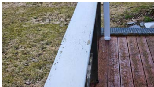
Malings avflassing av håndløper.
