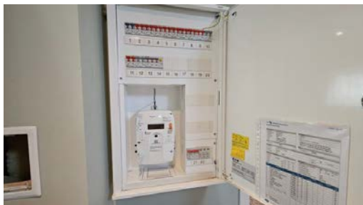
Kontroll av sikringsskap
