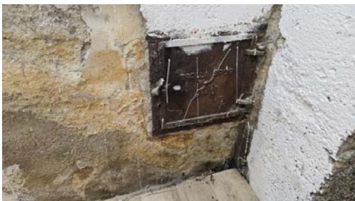
Kontroll av sotluke.
