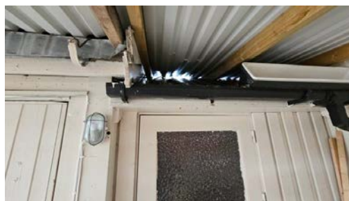
Ufagmessig legging av takplater.
