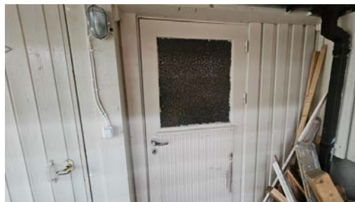
Kjellerdør av eldre dato.
