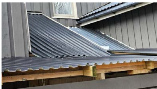
Ufagmessig legging av takplater.
