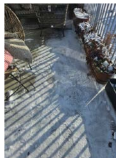
Bilde av balkong med snødekket området
