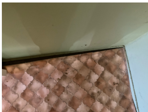
Gulvbelegg i kjeller
