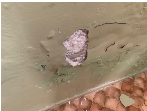
Malingsavskalling på vegger i kjeller.
