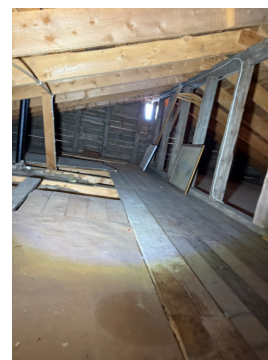
Mønebjelke med oppsprekninger.
