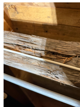
Mønebjelke med oppsprekninger.
