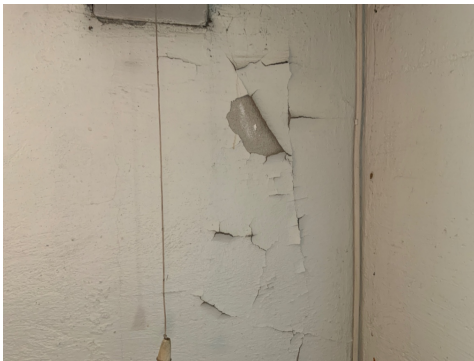
Malingsavskalling på vegger i kjeller.
