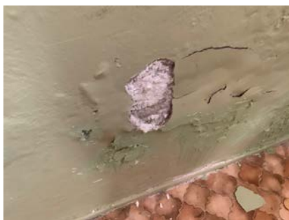
Malingsavskalling på vegger i kjeller.
