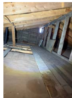
Mønebjelke med oppsprekninger.
