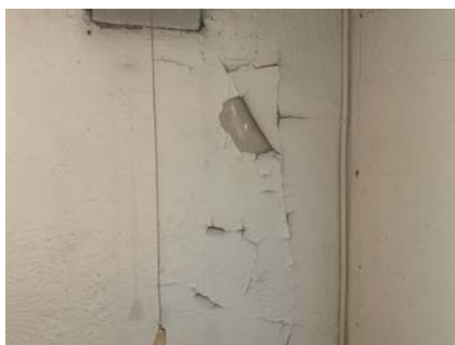
Malingsavskalling på vegger i kjeller.
