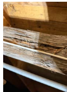
Mønebjelke med oppsprekninger.
