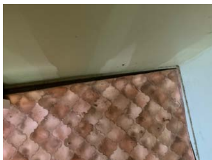
Gulvbelegg i kjeller
