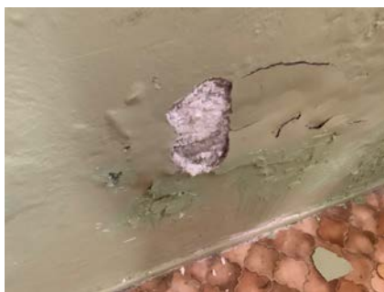
Malingsavskalling på vegger i kjeller.
