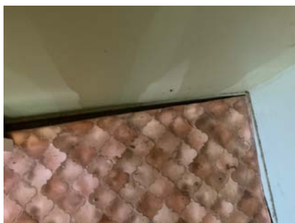
Gulvbelegg i kjeller
