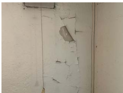
Malingsavskalling på vegger i kjeller.
