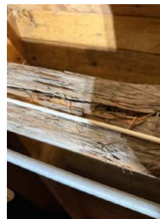
Mønebjelke med oppsprekninger.
