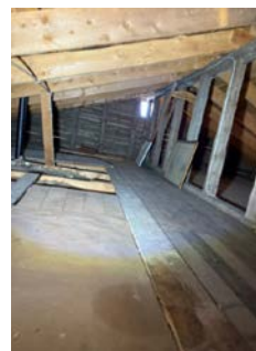
Mønebjelke med oppsprekninger.
