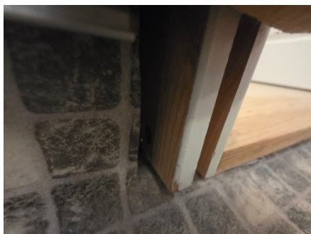
Belegget ved dør har ikke en høyde på 25mm
