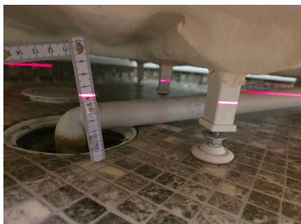
Belegget ved dør har ikke en høyde på 25mm
