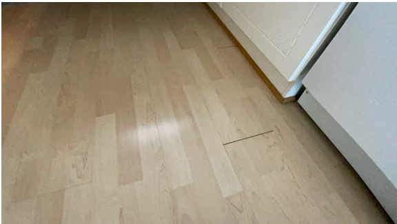
Løse skjøter i laminat
