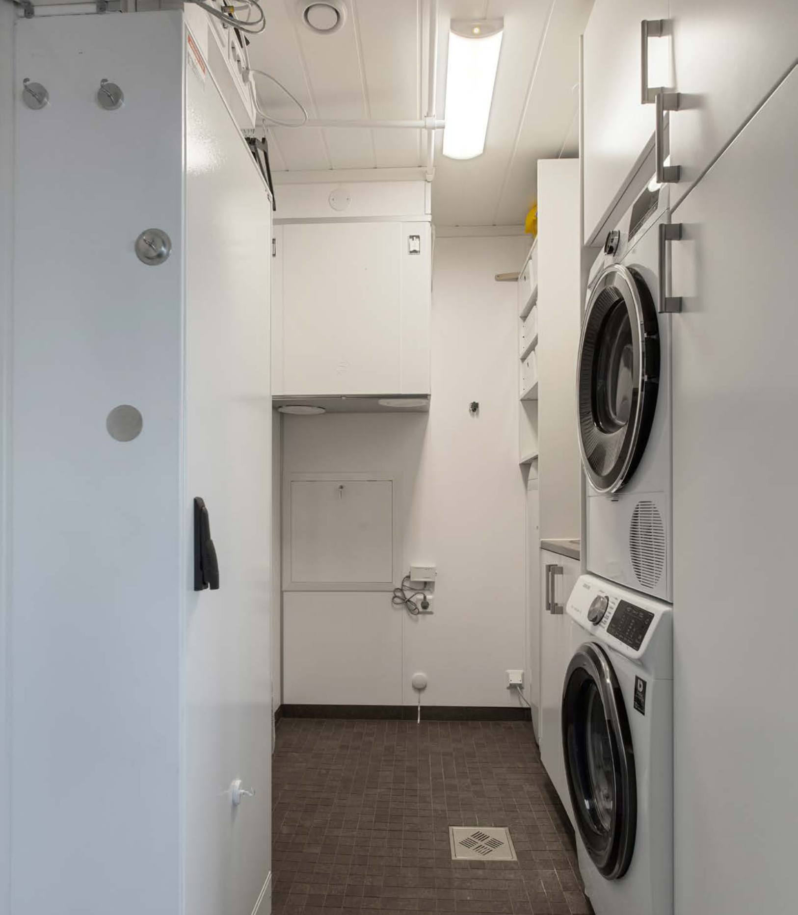
Leiligheten har eget vaskerom som også huser det meste av teknisk utstyr
