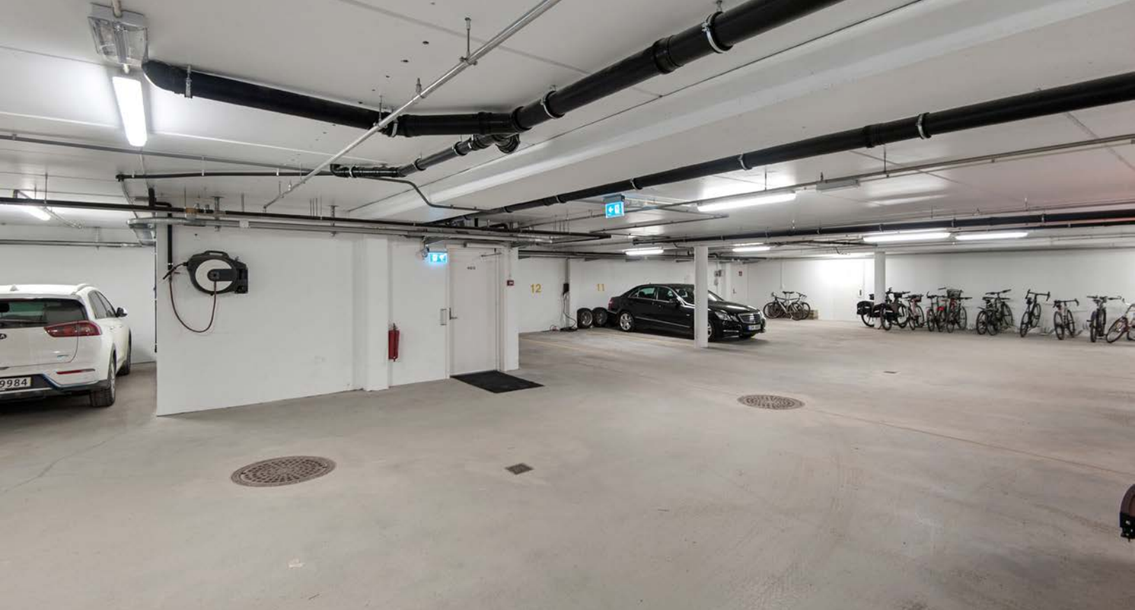
Fra parkeringskjelleren har en heis og trapp til leilighetens etasje
