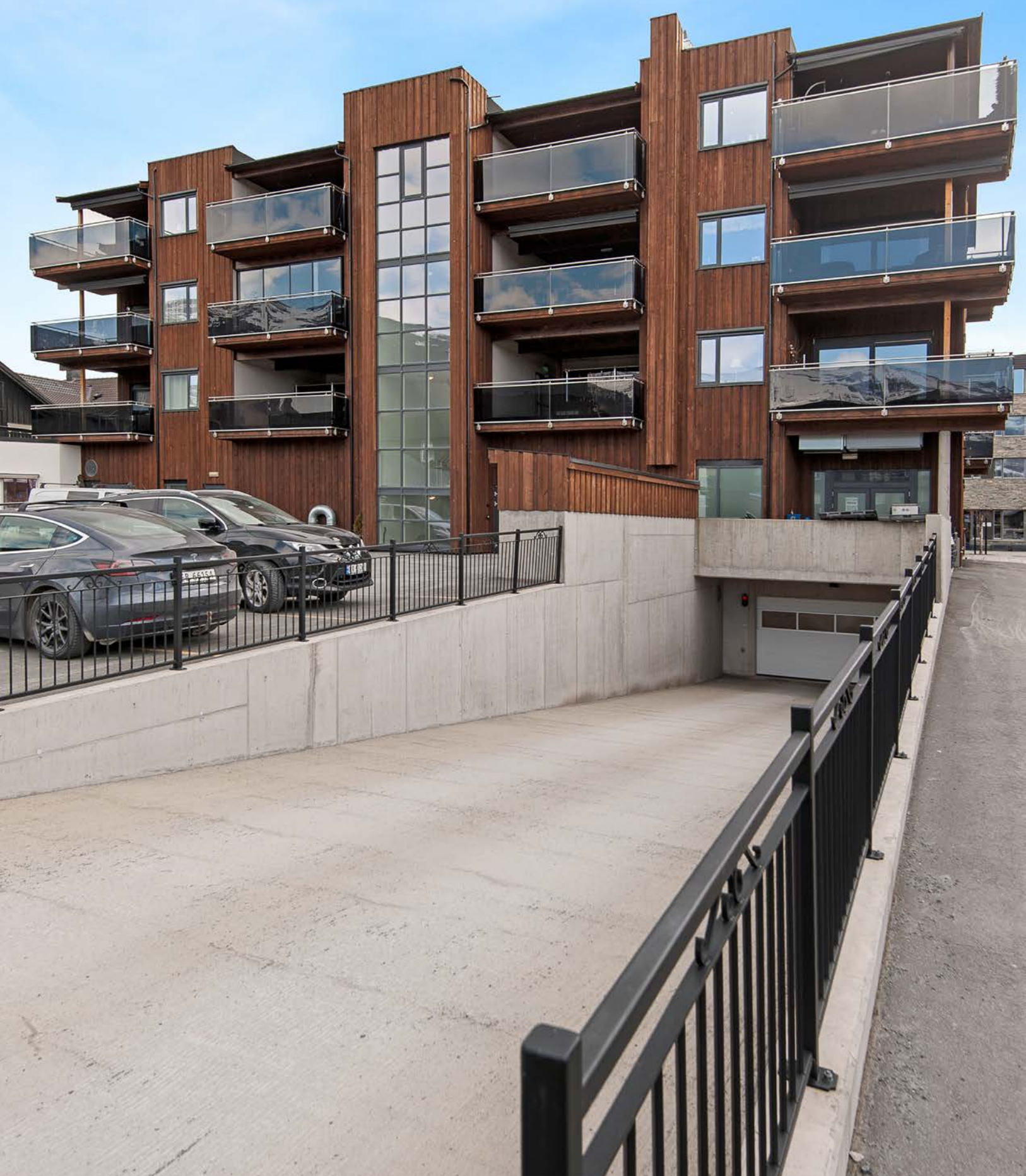
Nedkjøring til parkeringskjeller
