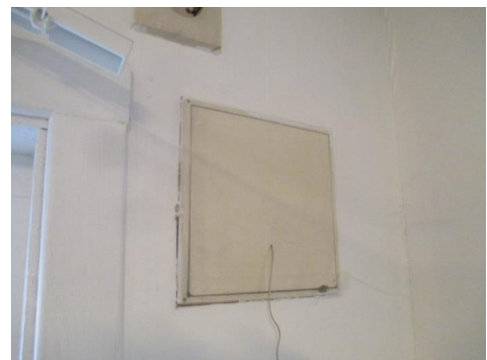
Ventil i ytterveggen.
