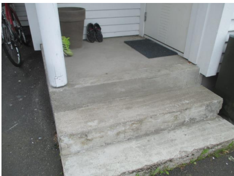
Støpt trapp med repos.
