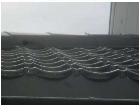
Deler av taktekkingen på tilbygget.
