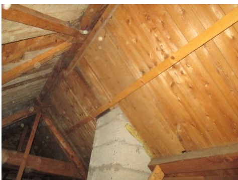
Deler av kaldtloftet over opprinnelig del.
