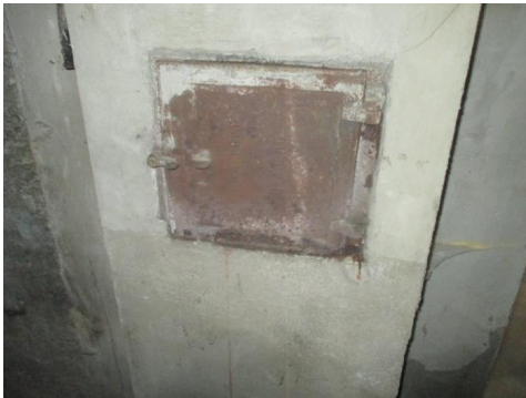
Sotluke i grovkjeller.
