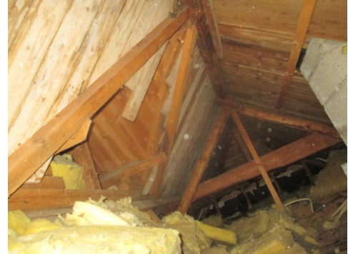
Åsetak med tilhørende sperrebukker og bord som undertak.
