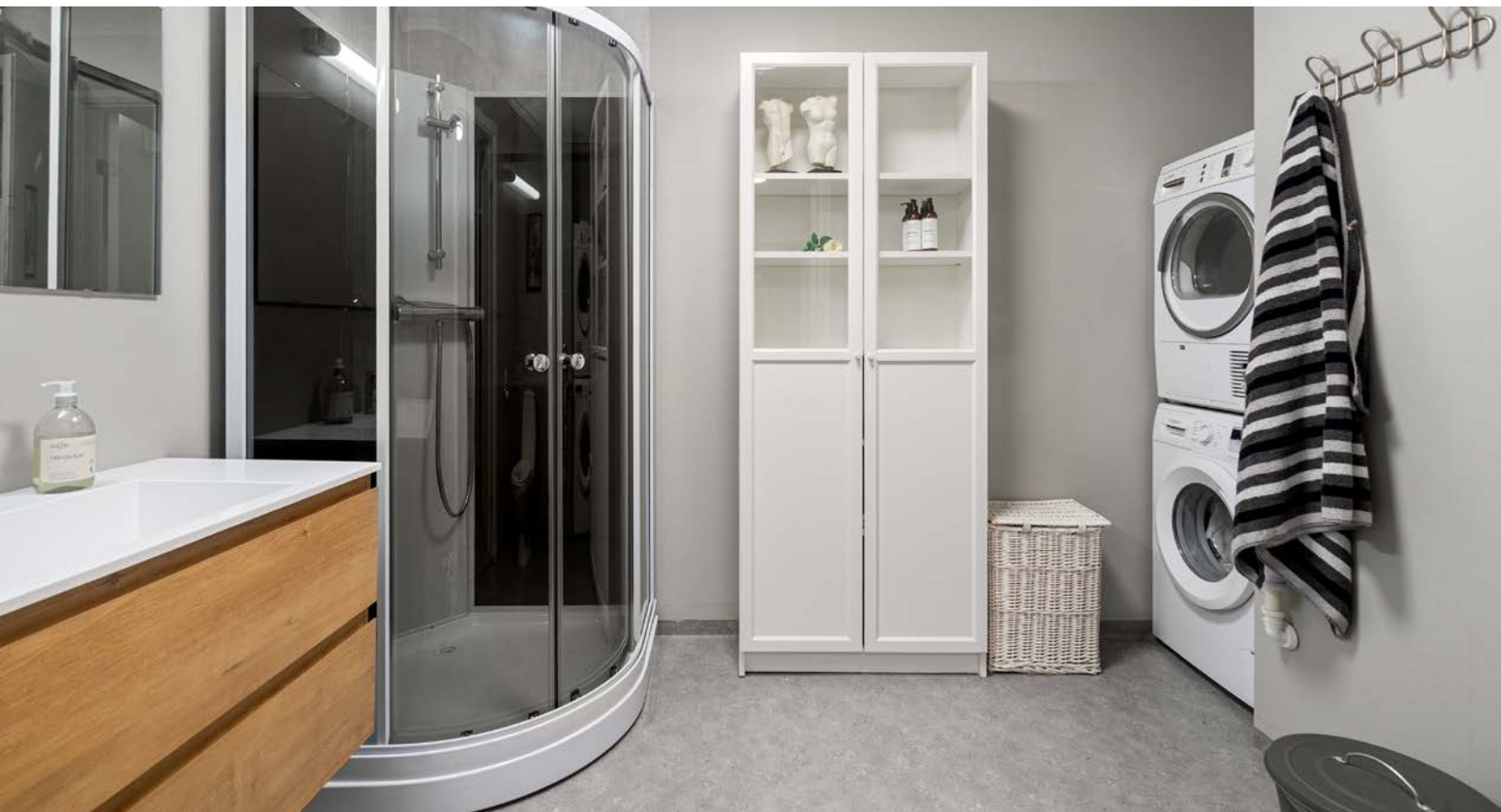
Bad/vaskerom med belegg på gulv og vegg bak dusjkabinett, ellers malte flater.
