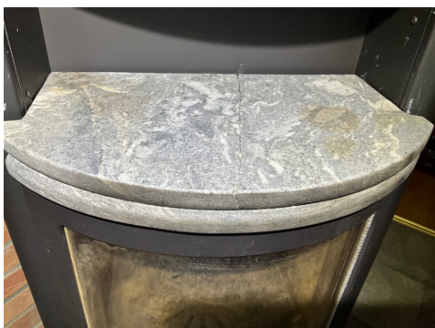
Sprekk i pyntestein av kleberstein
