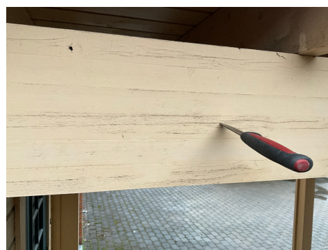
Slitt overflatebehandling på trevirke, noe bløtt trevirke i overflate på limtredeger.
