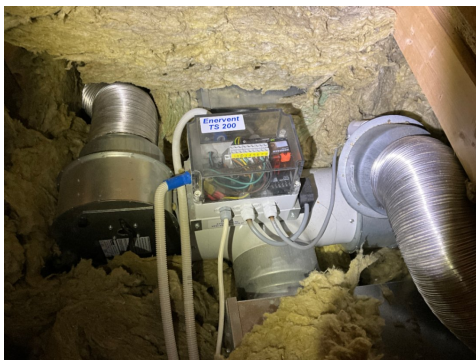
Ventilasjonsanlegg er innkasset på kott i loftsetasje
