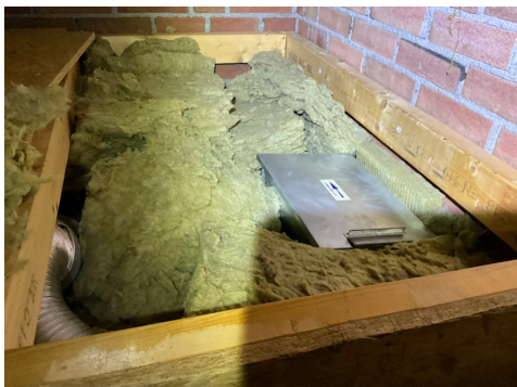
Ventilasjonsanlegg er innkasset på kott i loftsetasje
