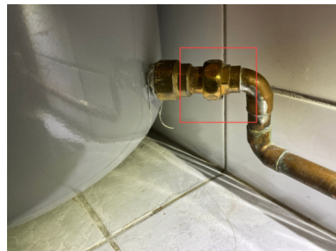
Drypper fra rørskjøt ved trykktank
