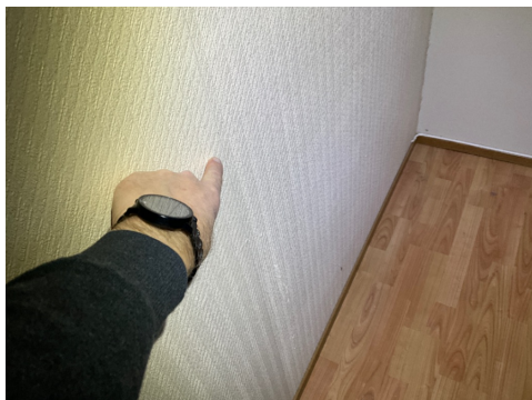
Bulning i overflate
