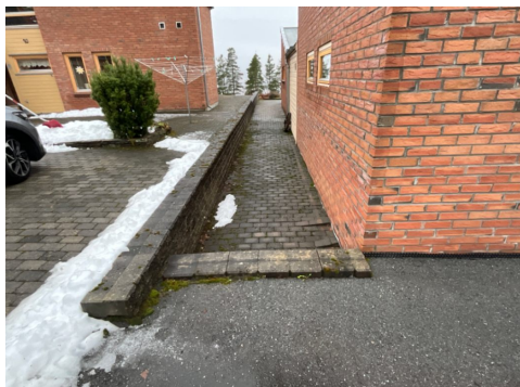
Forstøtningsmur sør på eiendommen
