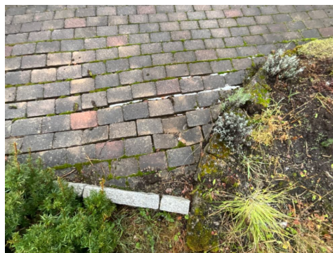
Masser siger ut mot skråning, dette medfører setninger på belegningsstein.
