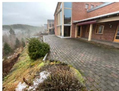
Masser siger ut mot skråning, dette medfører setninger på belegningsstein.
