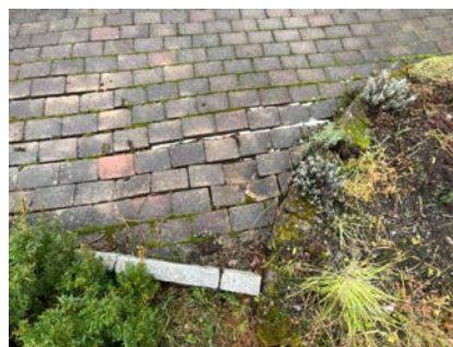
Masser siger ut mot skråning, dette medfører setninger på belegningsstein.
