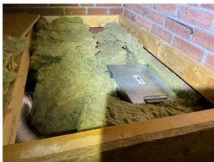
Ventilasjonsanlegg er innkasset på kott i loftsetasje
