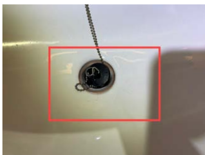
Riss i overflate rundt sluk i servant
