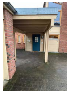
Slitt overflatebehandling på trevirke, noe bløtt trevirke i overflate på limtredeger.
