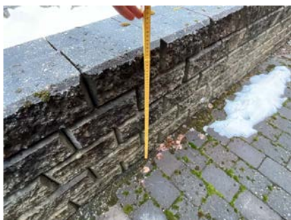
Høydeforskjell større enn 0,5 meter
