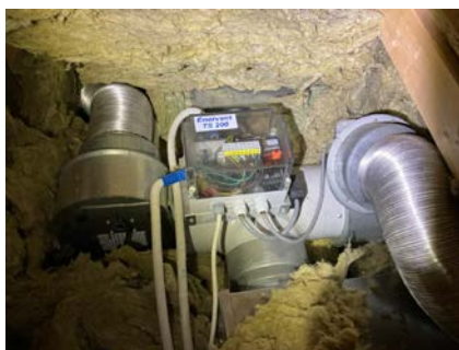
Ventilasjonsanlegg er innkasset på kott i loftsetasje
