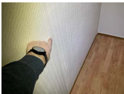
Bulning i overflate
