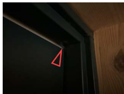
Glippe mellom dørblad og karm på hovedinngangsdør
