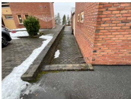
Forstøtningsmur sør på eiendommen
