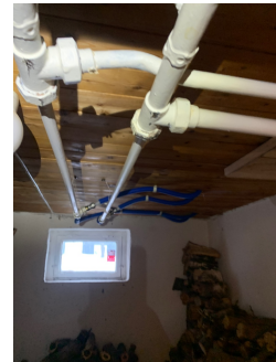
Stort sett originale kobberør, men som bildet viser er det enkelte plastrør av nyere årgang
