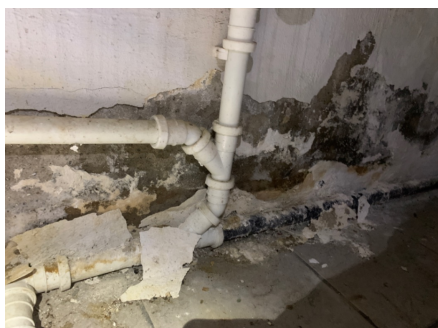
Synlig puss og malingsavflassing
