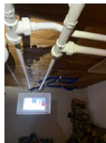
Stort sett originale kobberrør, men som bildet viser er det enkelte plastrør av nyere årgang
