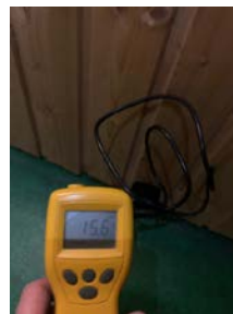
Fuktverdi i trevirke i badstuen i grenseland
