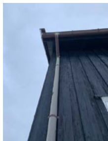
Nedløpsrør og renner av eldre årgang
