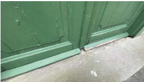
Råteskader port
