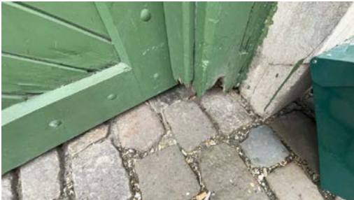
Råteskader port
