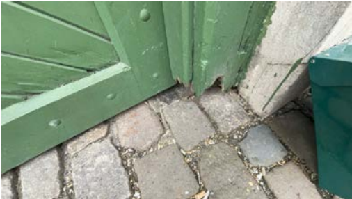
Råteskader port
