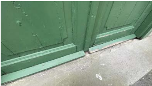
Råteskader port
