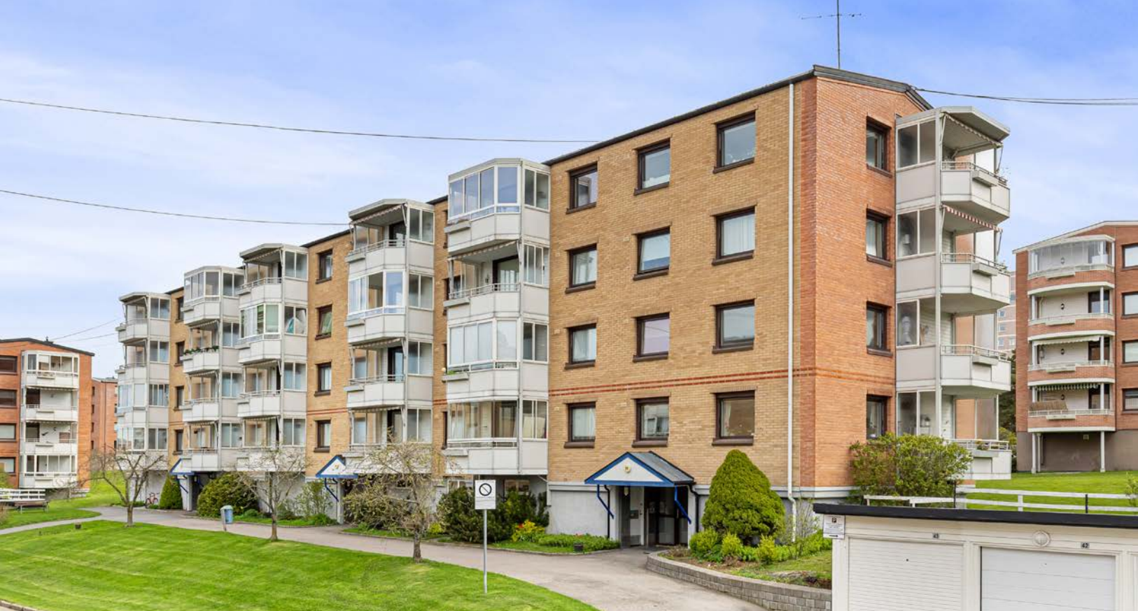
Borettslaget har pene teglstensfasader
