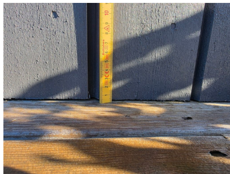
For kort avstand mellom kledning og terrassebord
