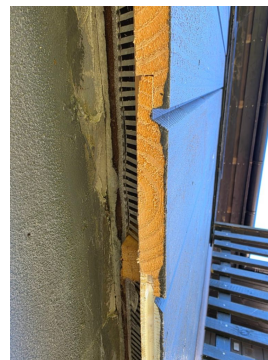
For kort avstand mellom kledning og terrassebord
