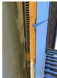
For kort avstand mellom kledning og terrassebord
