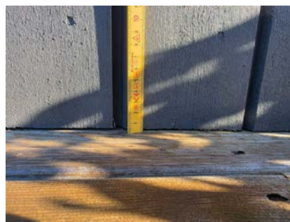
For kort avstand mellom kledning og terrassebord
