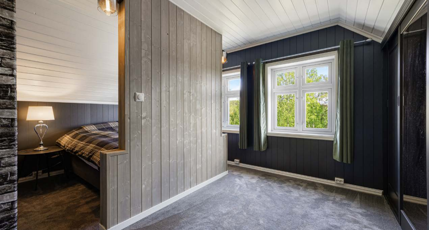
Hovedsoverommet har for lite dagslys og ikke godkjente rømningsveier iht. dagens krav til oppholdsrom.
