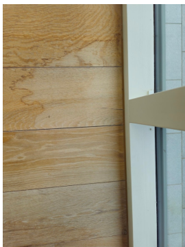
Fjernert gulvlist for å søke etter fuktighet i konstruksjon
