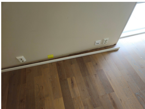
Fjernert gulvlist for å søke etter fuktighet i konstruksjon
