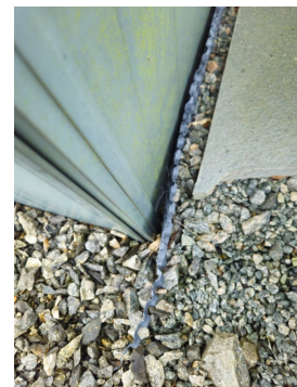
Synlig grunnmursplast uten klemlist
