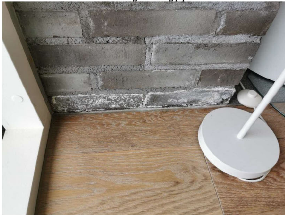
Vedlegg 1 - Foto 11. Innvendig saltutslag pipe
