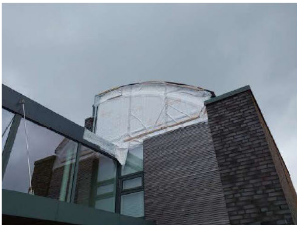
Fasade åpnet og midlertidig tettet, 30.05.2025
