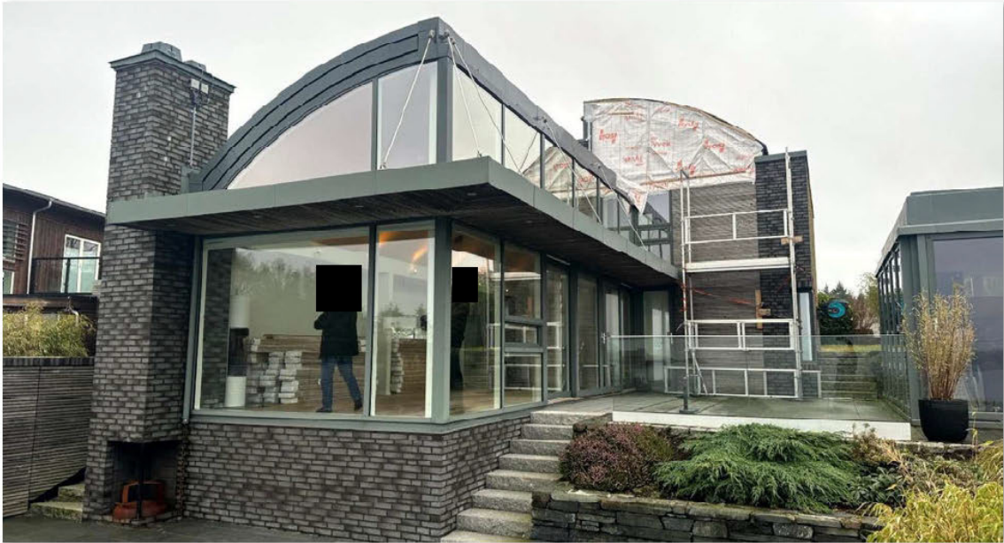
Bilde 6 – viser fasaden mot vest. Utettheter ved baldakin og glassflater er utbedret.
