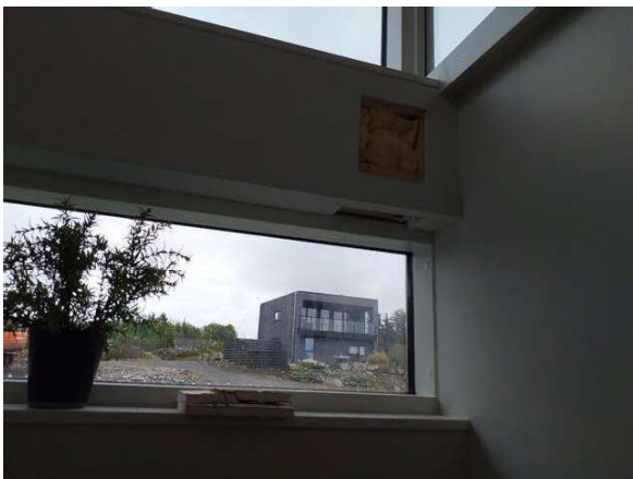
Åpnet innkassing i trappehull.
