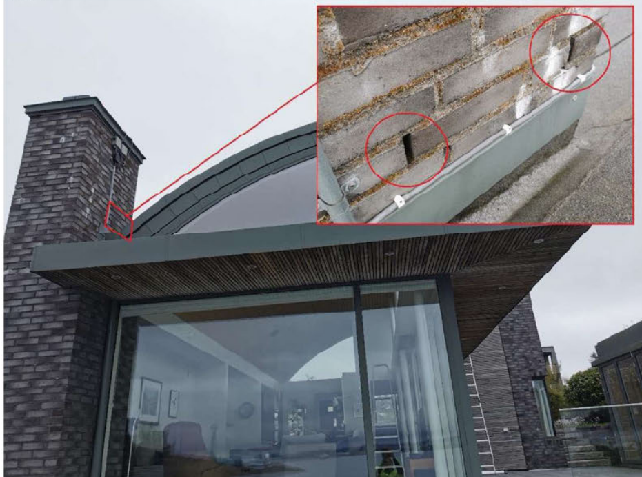
Vedlegg 1 - Foto 13. Utvendig pipe over tak. 4 slike hull er observert på 2 av sidene i pipeløp som går ned til stue.
