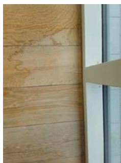
Fjernet gulvlister for å søke etter fuktighet i konstruksjon
