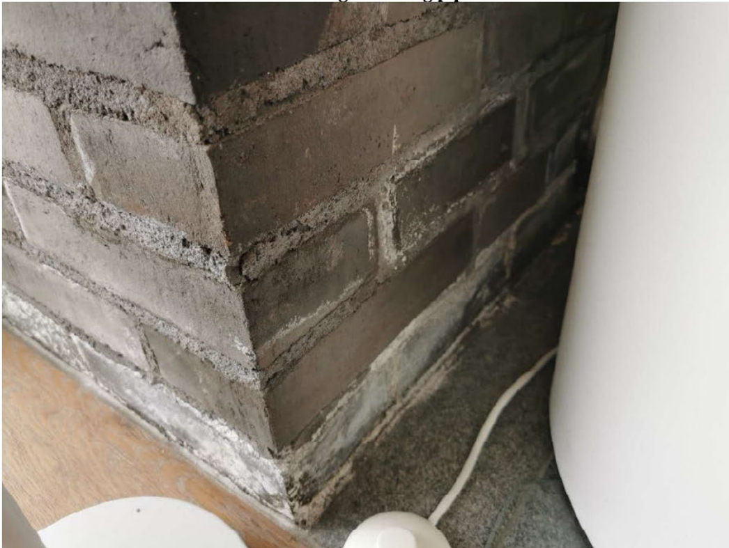
Vedlegg 1 - Foto 13. Utvendig pipe over tak. 4 slike hull er observert på 2 av sidene i pipeløp som går ned til stue.
