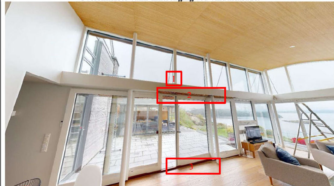
Vedlegg 1 - Foto 2. Oversiktsfoto vann-inntrenging ved vindusfasade.
