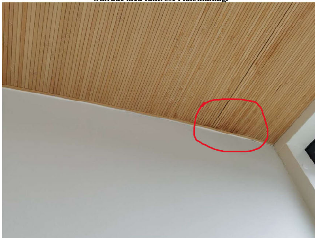
Vedlegg 1 - Foto 17. Område med fuktrose i tak/himling.
