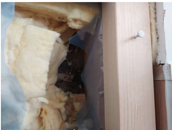
Muggdannelse på GU gips utvendig.
