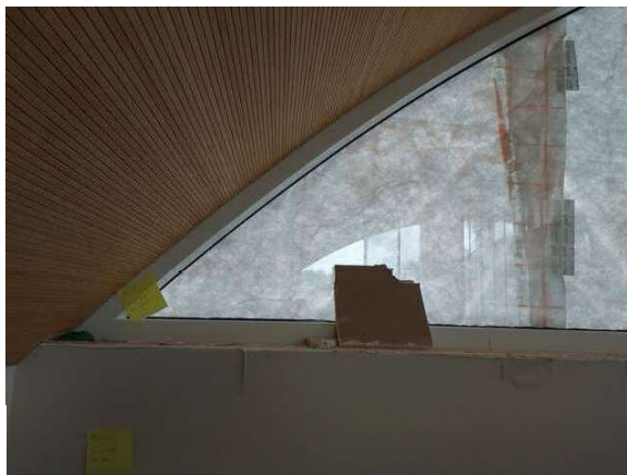
Gipsforing mot vindu tatt opp.
