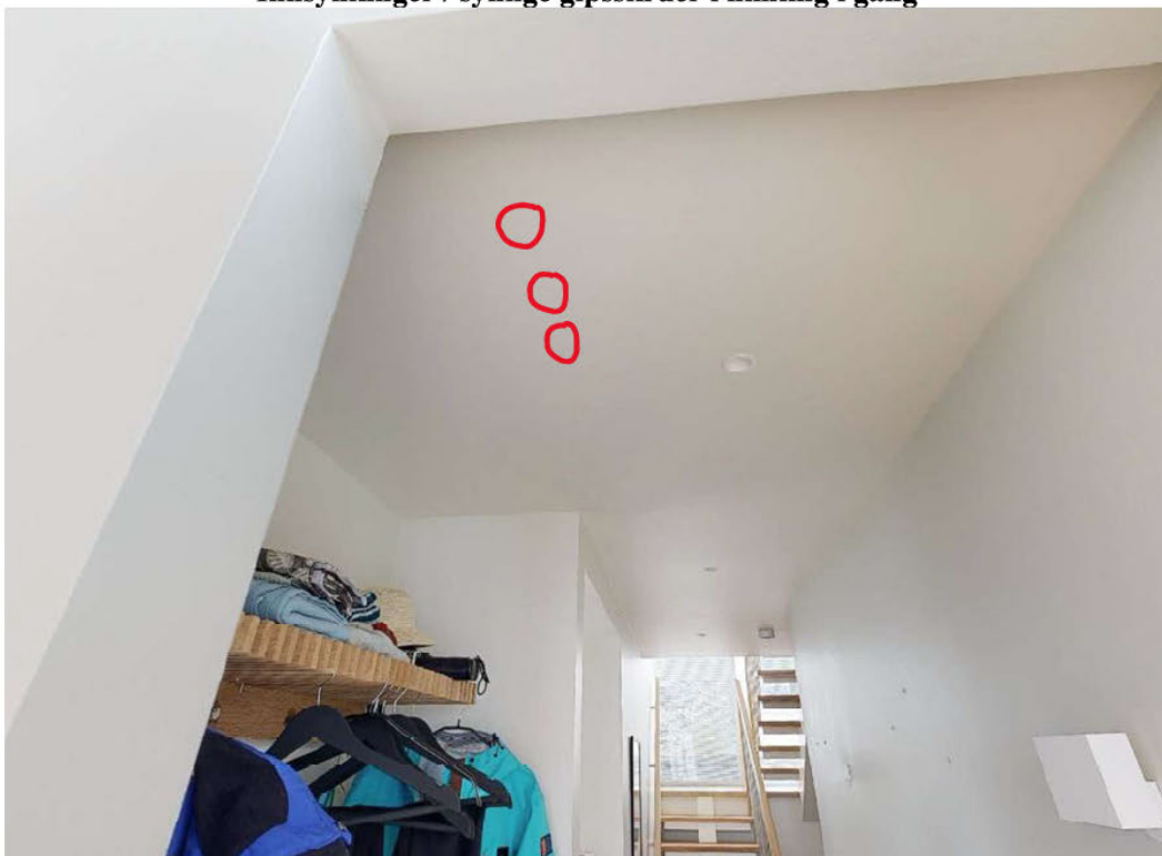
Vedlegg 1 - Foto 15. Innsynkinger / synlige gipsskruer i himling i gang
