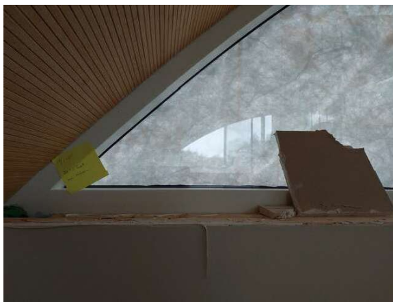
Gipsforing mot vindu tatt ut vekk.
