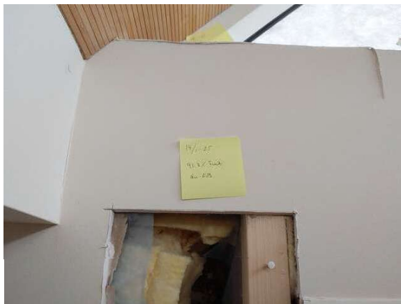
Åpning gips plate for kontroll av yttervegg.
