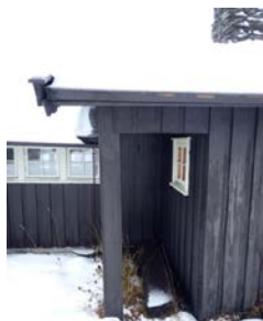
Viser bæresøyle på tilbygg med skjevhet.
