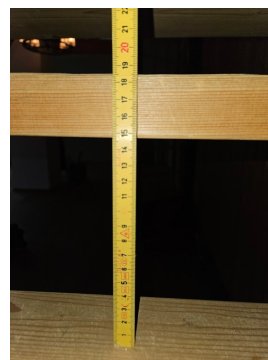
Åpninger mellom trinn i innvendig trapp er større enn dagens forskriftskrav.
