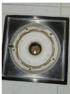
Synlig flik av membran ved klemring i sluk
