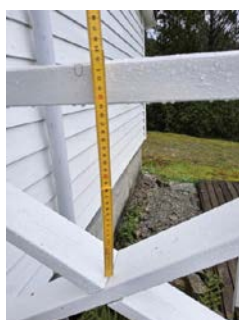
Åpninger i rekkverk er ikke i henhold til krav i dagens forskrifter.
