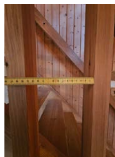
Åpninger i rekkverk er større enn dagens forskriftskrav til rekkverk i trapper.
