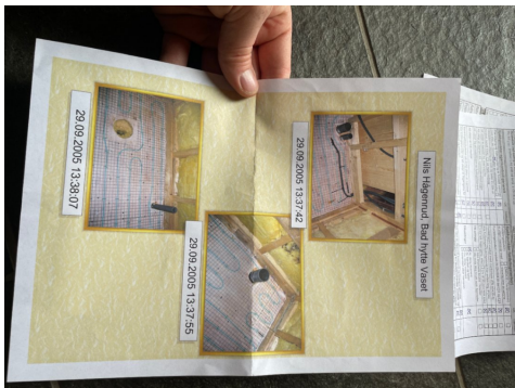
Bilder ved legging av varmekabler på bad.
