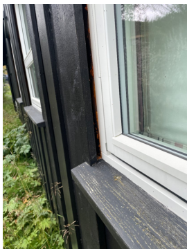
Ufaglig avslutning overgang yttervegg/vinduskarmer
