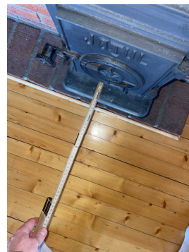
Ildfast plate mangler foran illegg på vedovn
