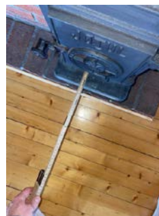
Ildfast plate mangler foran ilegg på vedovn
