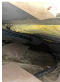
Det måles høyt fuktnivå i treverk med fare for ytterligere skadepotensiale.
